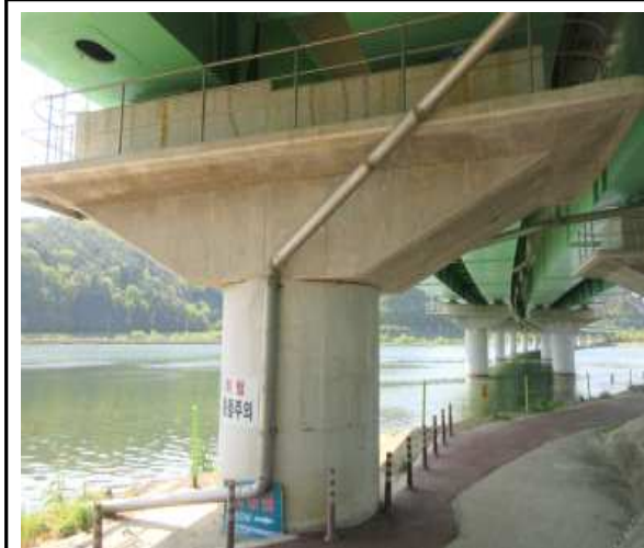
배수시설 S3 배수관(육교형) 상태양호
